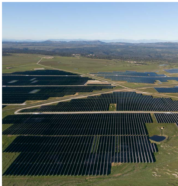
Operativ seit Dezember 2023: Die PV-Anlage Trujillo in der Region Cáceres
